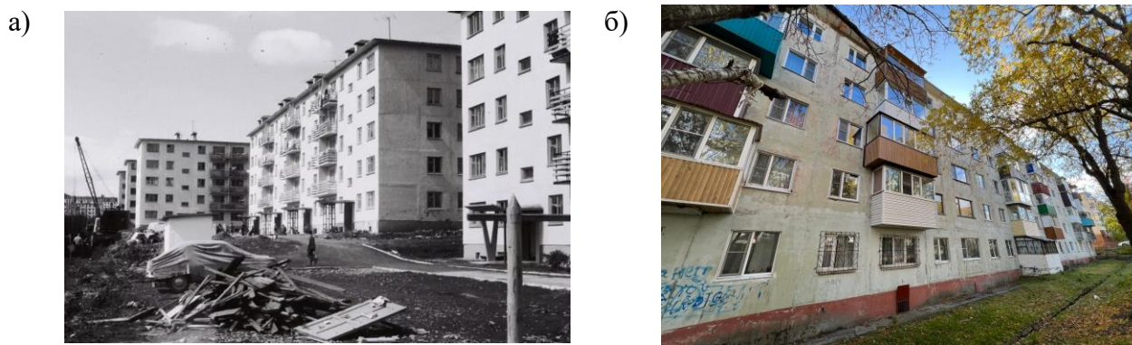
Рисунок 4 – Общий вид многоквартирных пятиэтажных домов типовой серии 1-464 АС-К, г. Петропавловск-Камчатский а) 70-е годы XX века; б) современное состояние (осень 2023 года)
