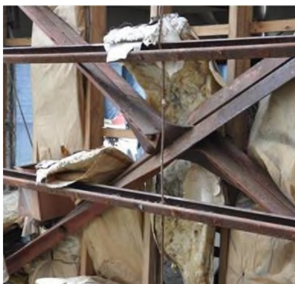
Пример отказа связевых элементов X-образной связи
