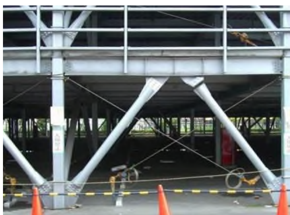
Пример отказа связевых элементов V-образной связи
