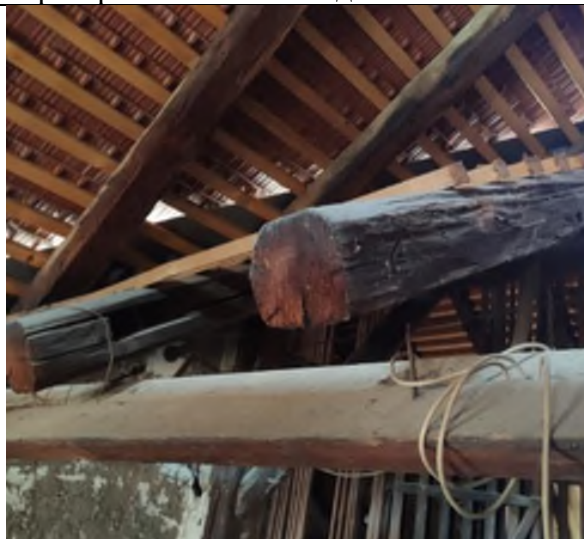
Пример отказа соединения
