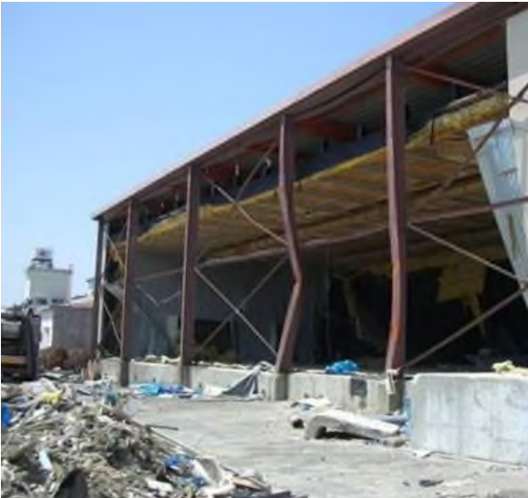
Пример потери общей устойчивости отдельных колонн
