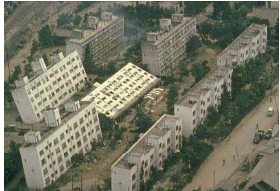
Ниигата: Разжижение грунта при Землетрясении 16 июня 1964 г. M = 7.5
